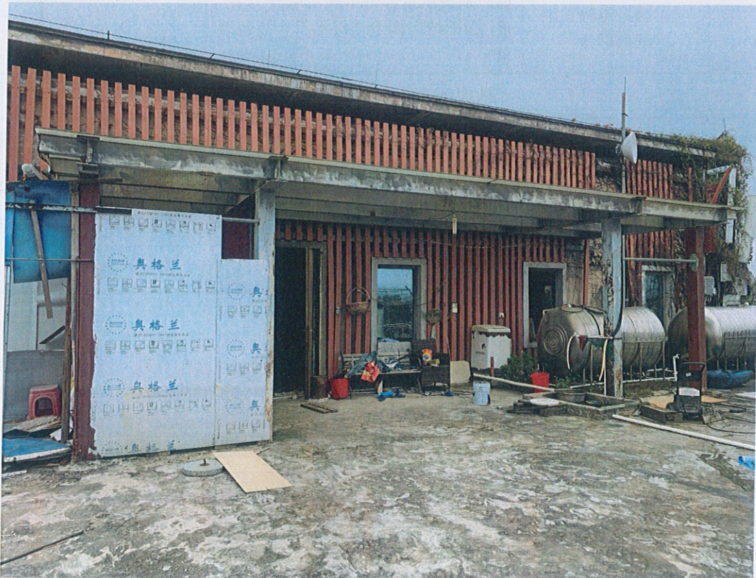
横琴滨海湿地展厅临时建筑工程
