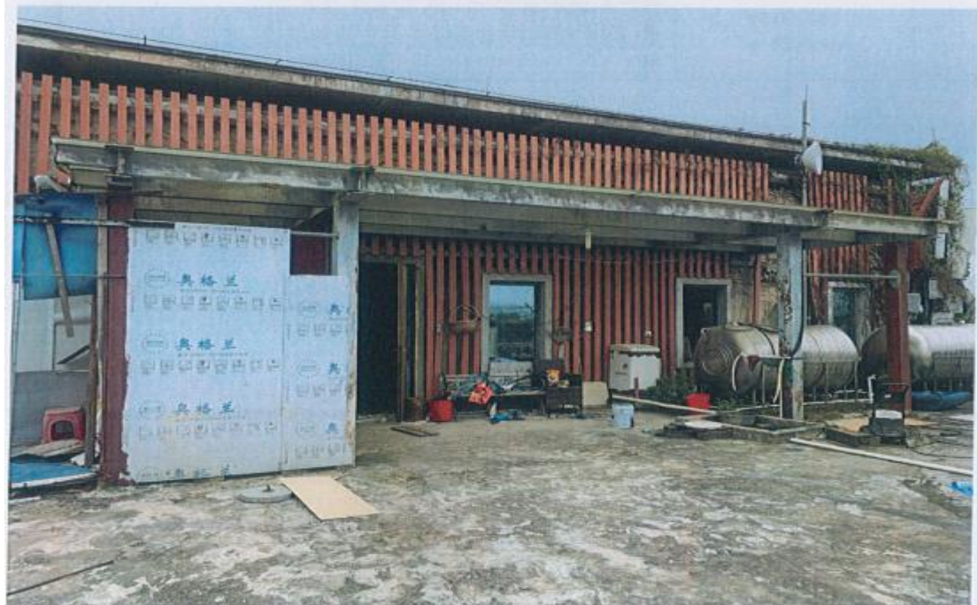
项目现状照片
